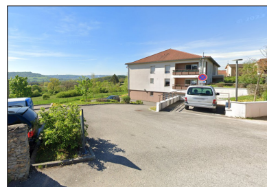
Accès existant au site et entrée de la future voie (SEMCODA)
